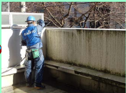
【施工中】 高圧洗浄状況。周囲への水の飛散に注意しながら 作業します。
