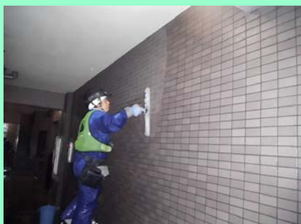
タイル面は薬品を塗布し、フラッシング等を行 い高圧洗浄を実施します。
